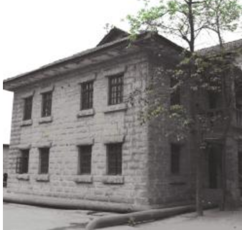
上个世纪五十年代内江糖业母厂银山糖厂专家楼
