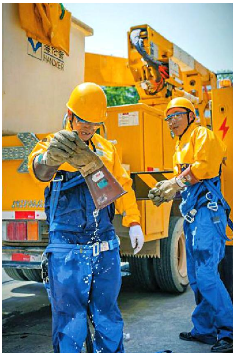
2022年8月16日，国网眉山供电公司电力抢修人员在带电作业后倾倒绝缘手套里的汗水（图片来源：四川日报）
